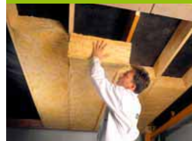
Монтаж теплоизоляции ISOVER враспор
